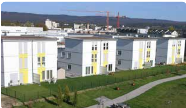
Wiesbaden - Künstlerviertel 1 + 2 83 Wohneinheiten, fertiggestellt 2009-2011
